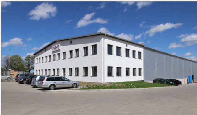
Bureau de vente et usine de production de Trąbki Wielkie, 7300 m 2
